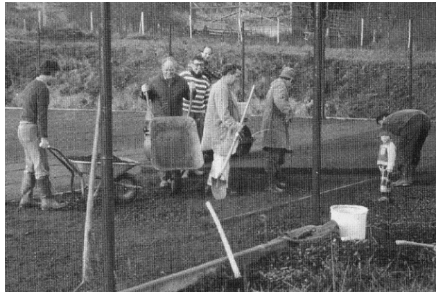
Bau der Tennisanlage 1980
