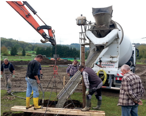
Fundament für Flutlicht
